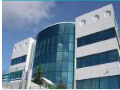
Arfen İnşaat A.Ş. / İSTANBUL
